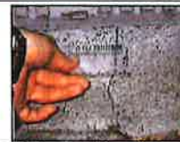
水平器による柱の傾きの計測
